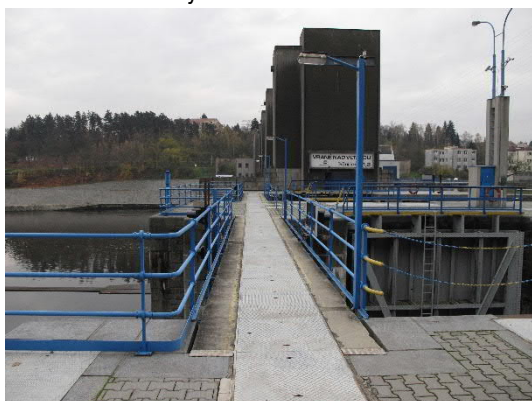
Přístup k jezovému pilíři přes ohlavi plavebních komor, most je však vybaven krycími plechy, které nejsou pojízdné pro těžká břemena
